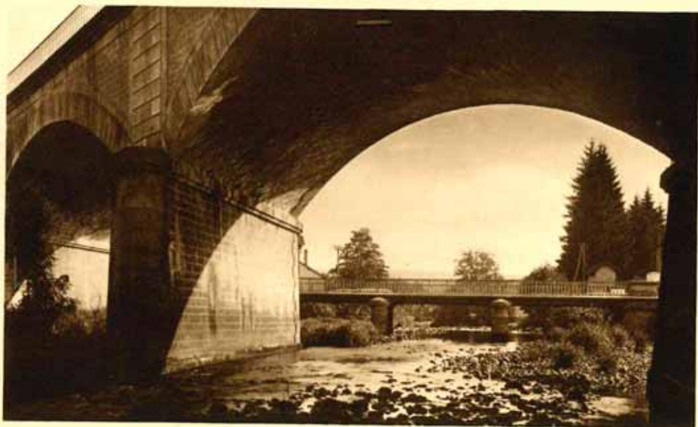
16136 c RILLEVILLERS — VIADUC ET PONT SUR LA SEMOUSE
